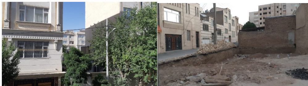
شکل ۳ - نمونه های از تخریب واحد مسکونی های و واحد مسکونی در انتظار تخریب بین دو واحد آپارتمان سازی شده
