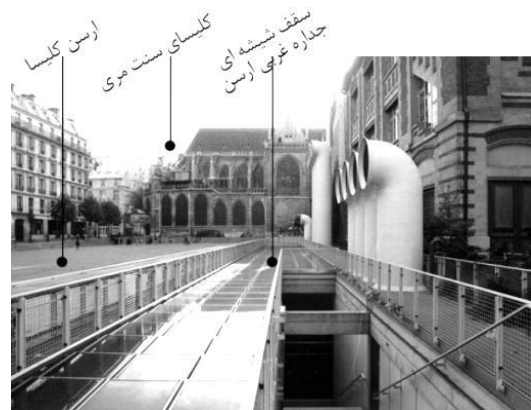
تصویر ۷. سقف شفاف فضاهای زیرزمینی مرکز IRCAM که سیرکولاسیون اطراف حوض مرکزی را مختل کرده است
